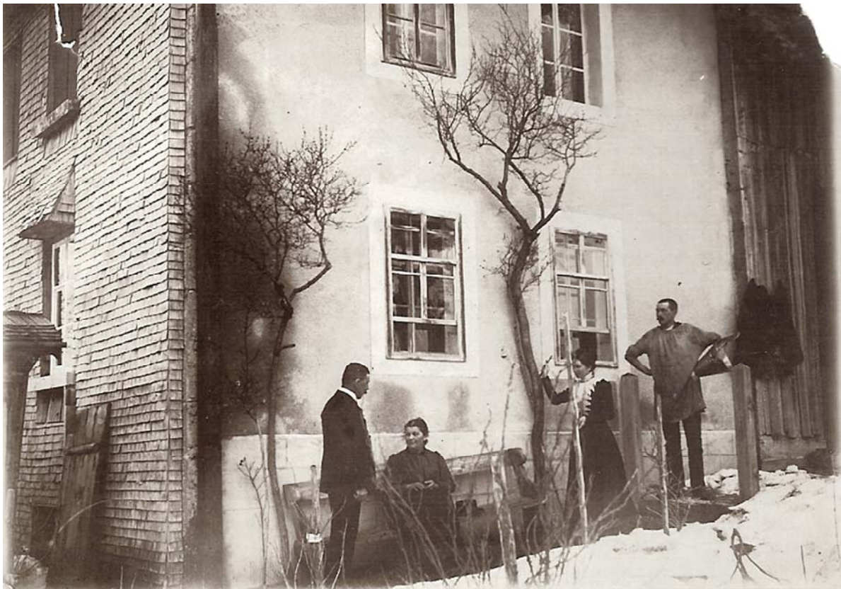
Le Mont-du-Lac. Devant la ferme de Alfred-Moïse Rochat en 1905. Les bancs se plaçaient encore plus volontiers sous le néveau, tout contre la partie habitable. Il suffisait d'ouvrir la porte du corridor, et hop, on pouvait s'installer sur le banc et tailler une petite bavette entre gens de la maison ou du coin.
